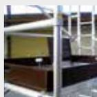
Les plinthes avec poignée sont en contreplaqué marine de 12 mm (pas de fixe plinthe).
